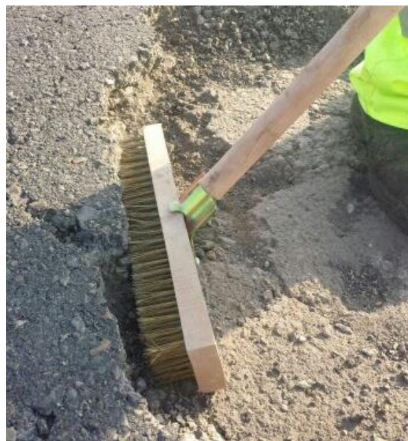
Figura 2. Eliminación de material degradado y semisuelto en bordes y fondo del bache, mediante cepillo de púas
