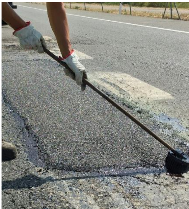
Figura 7. Sellado con emulsión del contacto de la superficie reparada del bache con el pavimento original
