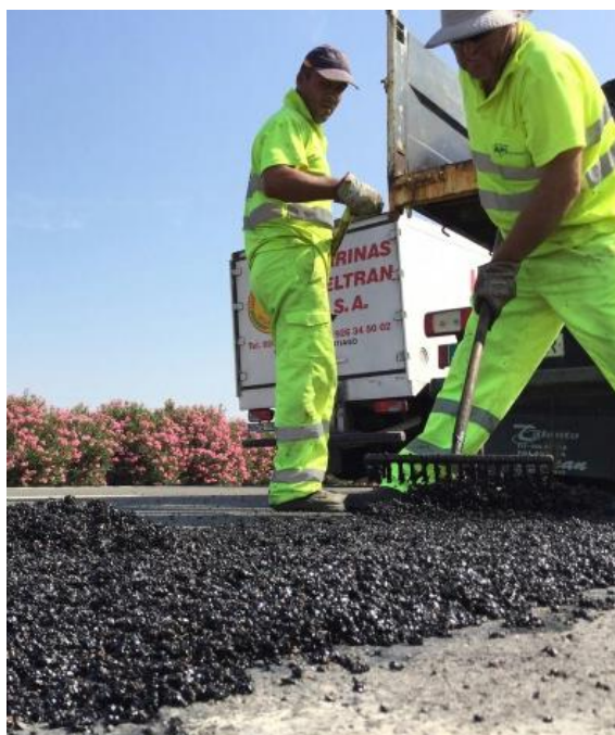
Figura 5. Vertido y extendido manual de la mezcla bituminosa en frío.
