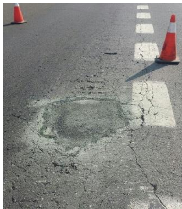
Figura 8. Resultado final reparación urgente del bache con mezcla bituminosa en frío
