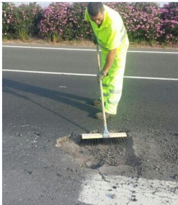
Figura 3. Barrido del bache. Eliminación de material suelto y polvo.
