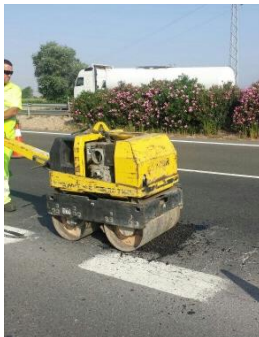
Figura 6. Compactado de la mezcla bituminosa en frío
