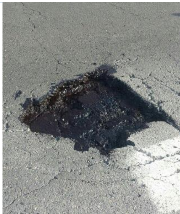
Figura 4. Riego de adherencia aplicado
